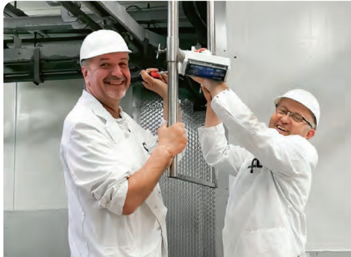
In einem Rinderschlachtbetrieb in Niederösterreich wurden zwei Classifai-Boxen mit spezieller Kamertechnik installiert. Foto: Foodfair
